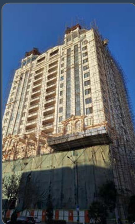
پروژه برج سفید
